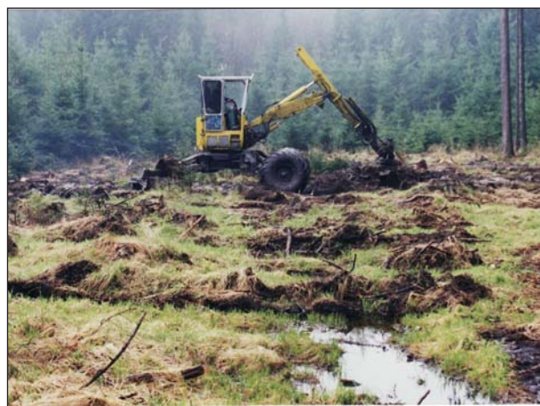
Obr. 42: Provedení kopečkové přípravy půdy malým bagrem spojené s obnovou odvodňovacího systému. Foto: Kovář.
